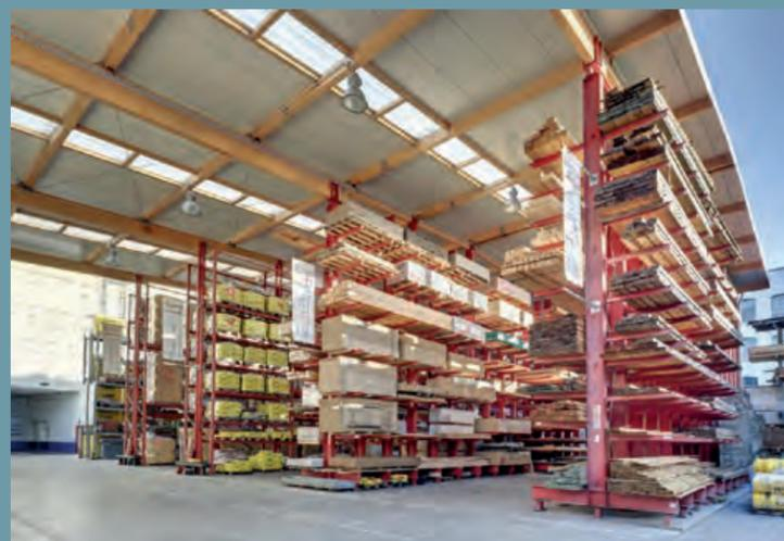
Offene Regalhalle. Kombination aus Kragarm- und Palettenregalen als tragende Konstruktion für das Dach. Lichtdurchflutet, mit großer Spannweite für Lkw- Durchfahrt.
