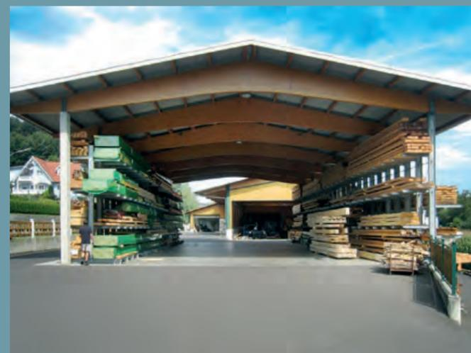
Offene Kragarm-Regalhalle mit zwei doppelzeiligen verzinkten Kragarmregalen. Moderne Satteldachkonstruktion mit Trapezblecheindeckung. Große Fundamentplatte
