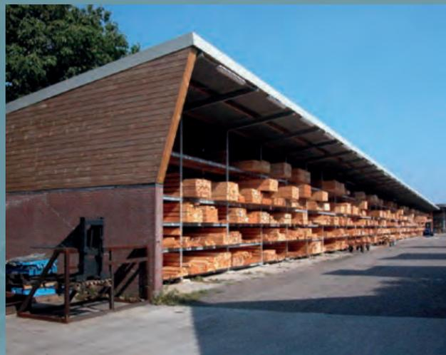
Dreiseitig geschlossene Palettenregal-Halle für die Lagerung von Holz mit verschiedenen Sortimenten und Abmessungen in Tiefenrichtung. Großer Dachüberstand.
