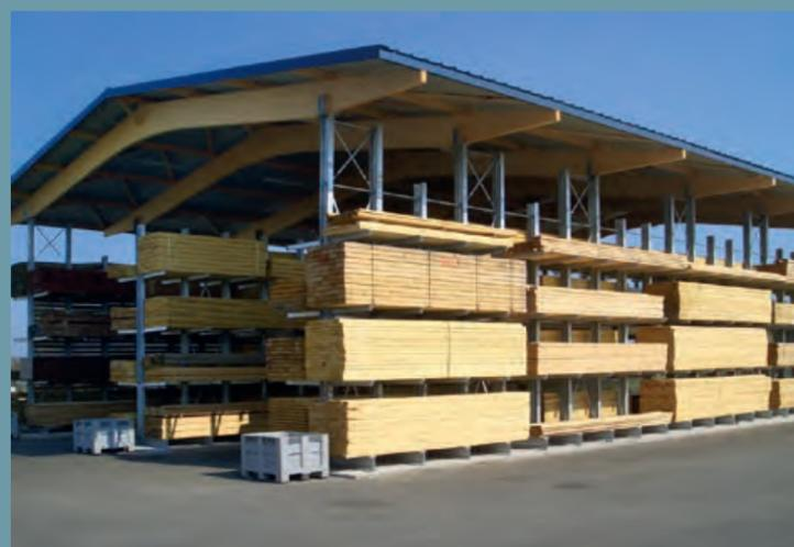
Offene Kragarm-Regalhalle mit drei doppelzeiligen verzinkten Kragarmregalen. Moderne Satteldachkonstruktion mit 10 m Spannweite.
