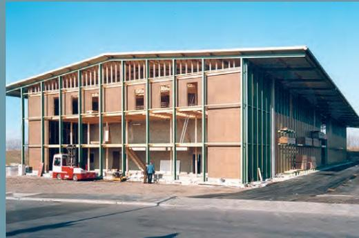
**Regal-Hallenbau – geschlossene Bauweise:** Inklusive Dacheindeckung und Wandverkleidung. Der Einbau von Toren, Fluchttüren und Entwässerung macht den Regal-Hallenbau komplett.
