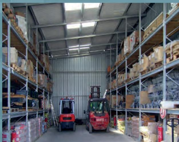
Palettenregal-Halle bei einem Baustoffhändler. Komplett mit Dach und Wand aus Stahltrapezblech. Inkl. Rolltor und Lichtkuppeln. Zusätzlicher Schutz der Regalrahmen gegen Anprallkräfte.
