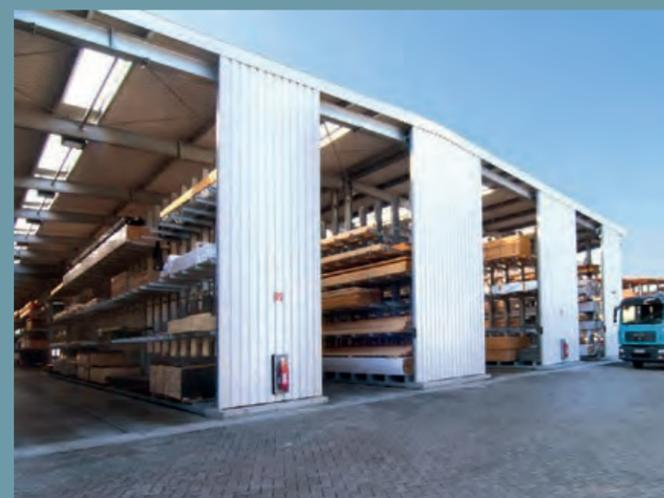
Holzlager mit Dach- und Wandverkleidung. Komplett verzinkte Kragarmregale mit Führungsschiene als Achmalganglager. Lichtbänder in jedem Gang.
