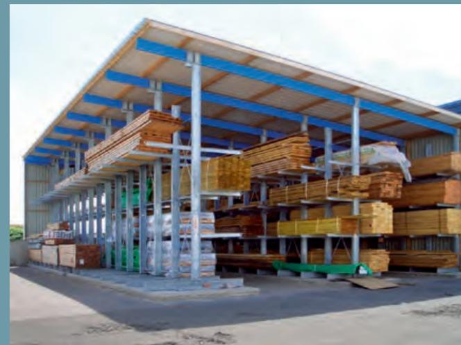
Halb geschlossene Kragarm-Regalhalle mit feuerverzinkten Regalen. Dach und Wand aus Stahl-Trapezblech. Harmonischer Anbau an eine vorhandene Halle
