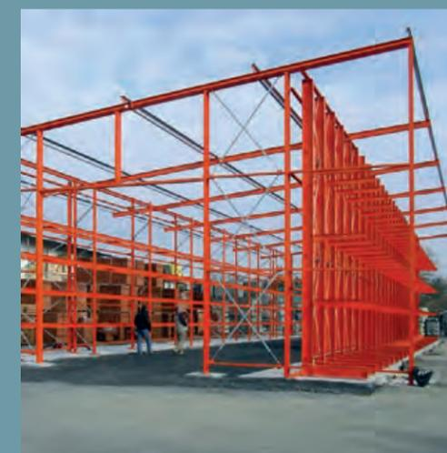
Regalkonstruktion, bestehend aus Kragarm- und Palettenregalen. Unterkonstruktion inklusive Giebelwand, kurz vor der Verkleidung. Block- und Köcherfundamente statisch berechnet.
