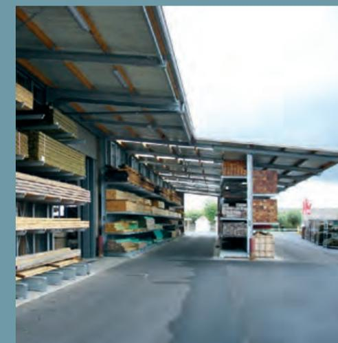
Komplett geschlossene Regalhalle mit zusätzlichem offenen Anbau einer überdachten, doppelseitigen Kragarmregalzeile. Inkl. Beleuchtung und Lichtbändern über der Durchfahrt.
