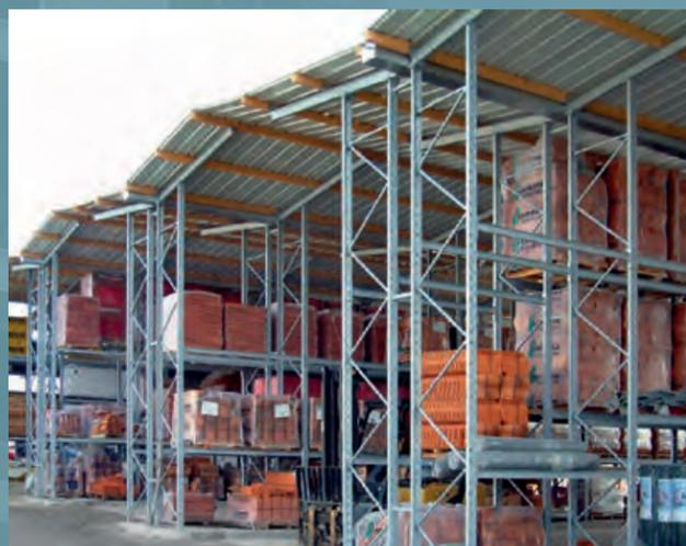
Offene Palettenregal-Halle für die Lagerung von Baustoffen. Doppelzeiliges Regal, komplett verzinkt, auf Blockfundamenten montiert.
