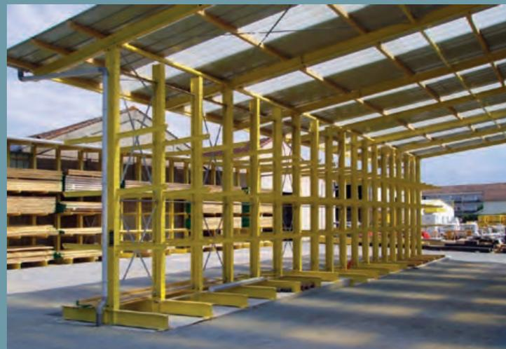
Offene Kragarm-Regalhalle im Holzhandel. Komplett mit Trapezblech-Dacheindeckung inkl. Lichtbänder, Regenrinne und Fallrohr. Blockfundament mit Höhenausgleich.
