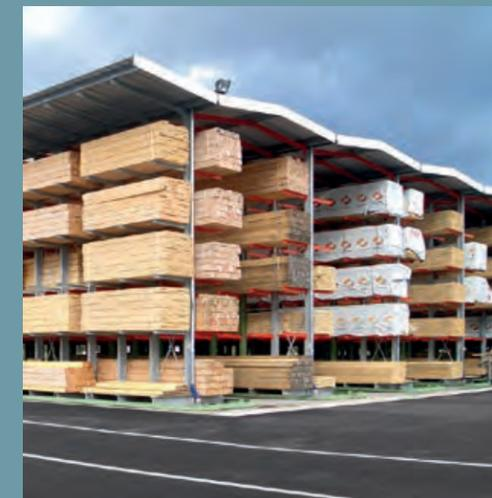
Regalhalle bei einem großen Holzhändler. Dacheindeckung aus Stahl-Trapezblech, unterbrochen durch Lichtbänder. Als Schmalganglager inkl. Führungsschienen konzipiert.
